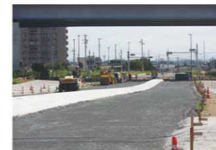
県道 豊田・刈谷線建設中
